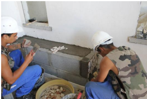
Formation maçonnerie au GSMA
